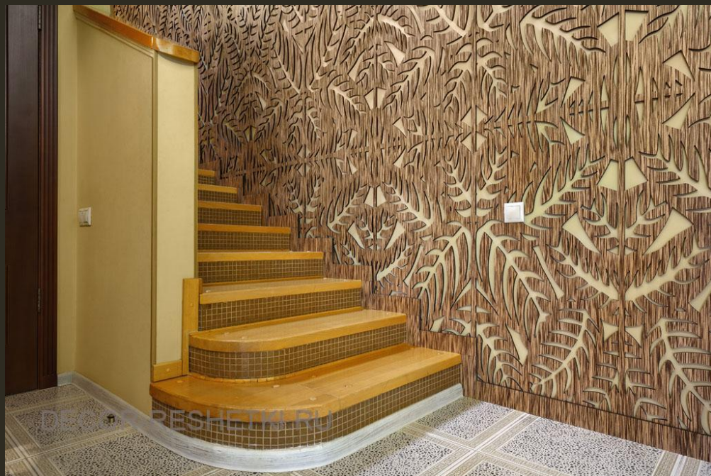
Изготовление и монтаж стеновых панелей, г.Истра, пос.Пионерский
