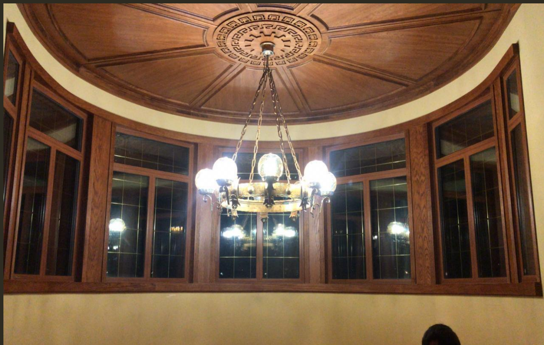
Изготовление и монтаж кессонных потолков и отделка оконных проемов, г.Истра, пос.Пионерский
