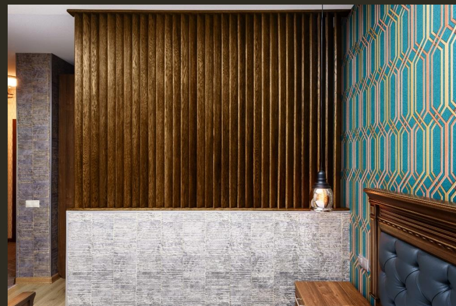
Изготовление и монтаж реечной перегородки, г.Москва, ул.Чечерский проезд
