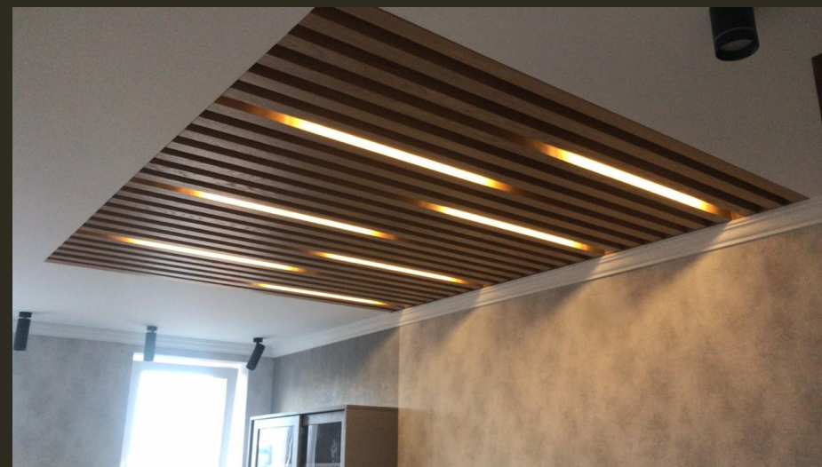
Изготовление и монтаж реечного потолка, г.Москва, Пресненский Вал, д.14
